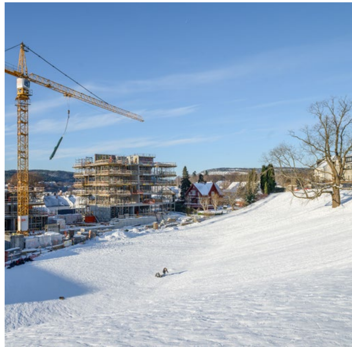
Februar 2025 - dekke på 7 etasje er snart klart for støping.
